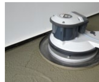
Заглаживание бесшовного пола
