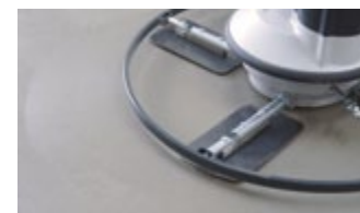
Заглаживание с помощью лопастей
