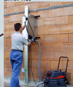
Станок S25 с направляющей шиной W25
